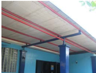
Gambar 3.3. Lapisan insulasi pada atap
